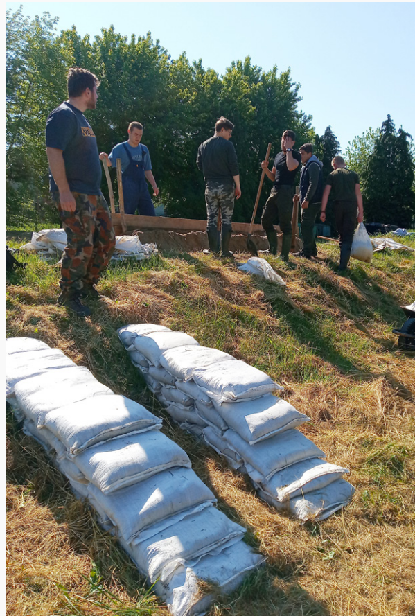
VIZSGAFELADAT - BORDÁS MEGTÁMASZTÁS, VALAMINT NYÚLGÁT VÍZOLDALI PALLÓFALLAL
