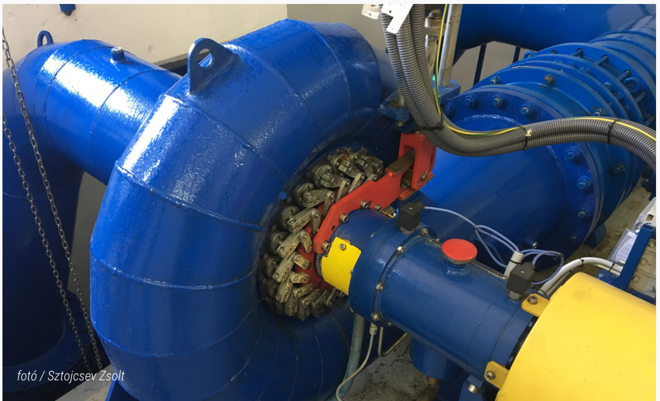
VÍZSZINTES TENGEYŰ TÖRPE FRANCIS TURBINA
