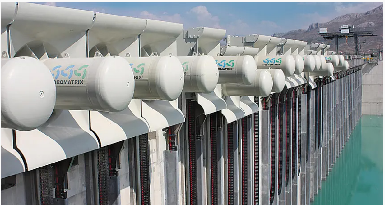
5. ÁBRA: HIDROMÁTRIX RENDSZER (JELLEMZŐEN ELZÁRÓSZERKEZETRE SZERELHETŐ) (forrás: ANDRITZ)
