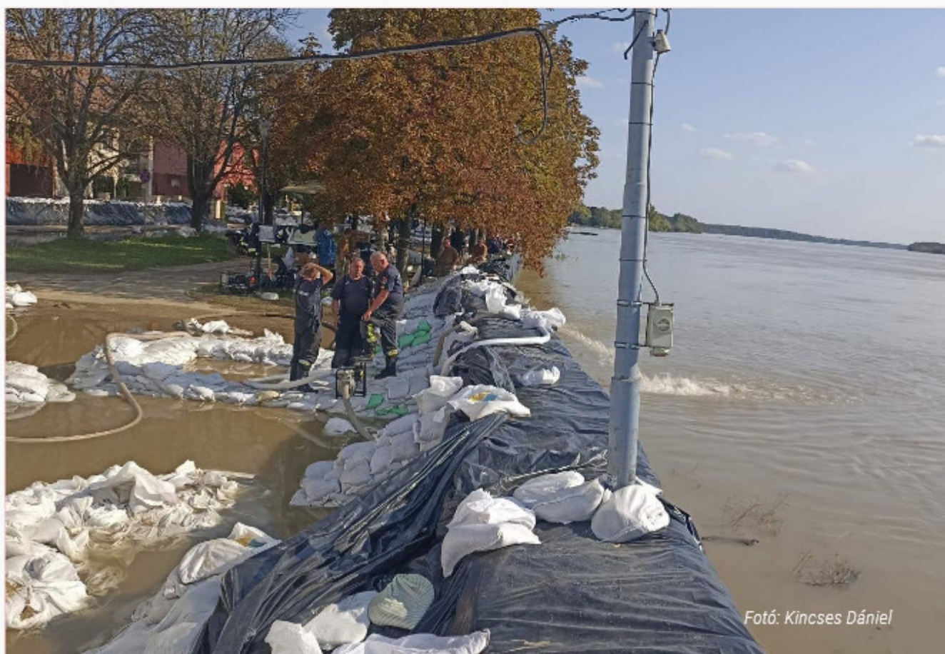
1. KÉP: SZIVATTYÚZÁS A VÁCI LISZT FERENC SÉTÁNYON KIÉPÍTETT IDEIGLENES VÉDMŰVÖN
