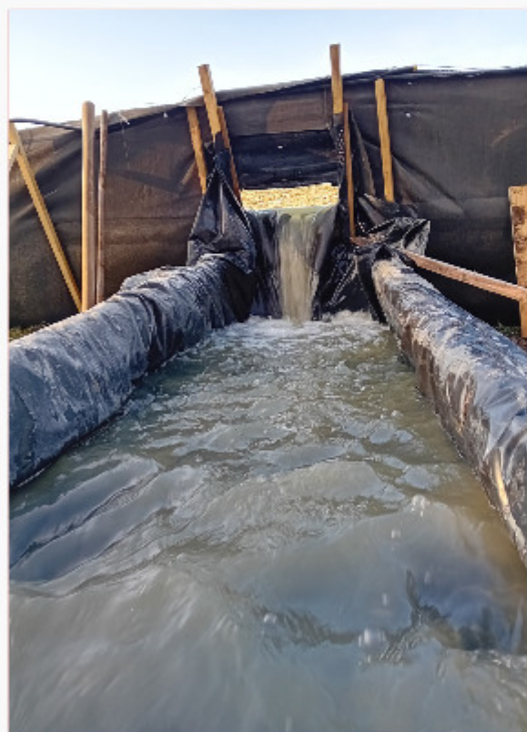
8. KÉP: CSURGALÉKVÍZ MINTAVÉTELI HELYEK KIALAKÍTÁSA
