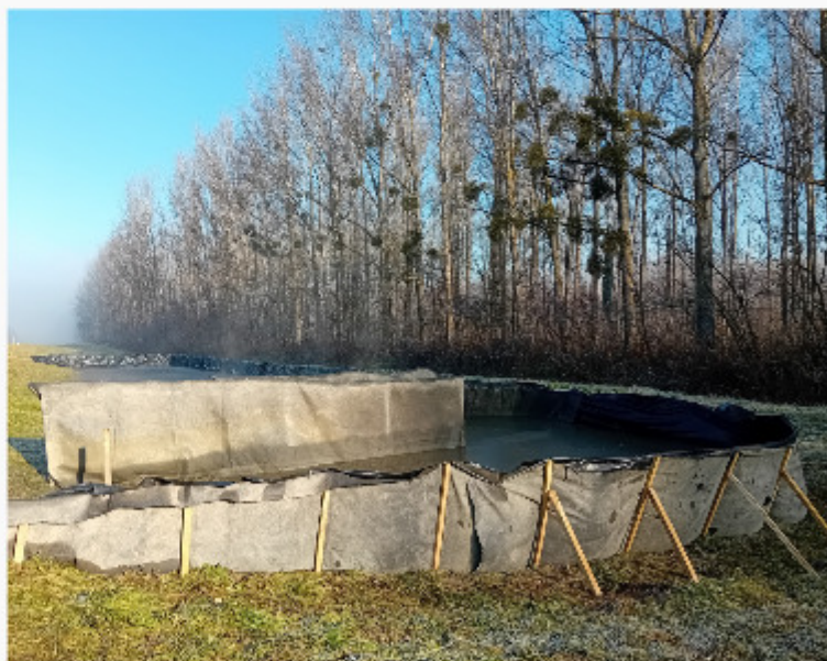
2. KÉP: HIDROSZEPARÁCIÓS ZAGYKAZETTA
