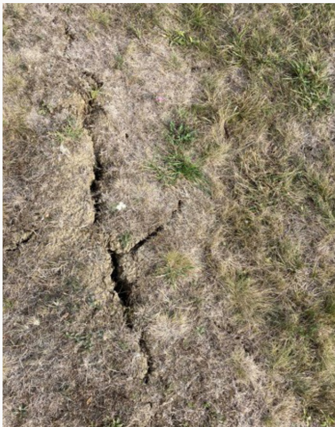
1. A ÉS B KÉP: REPEDEZETT TÖLTÉSKORONA-BURKOLAT ÉS A VÍZOLDALI RÉZSÚN MEGJELENŐ MERŐLEGES REPEDÉSEK
