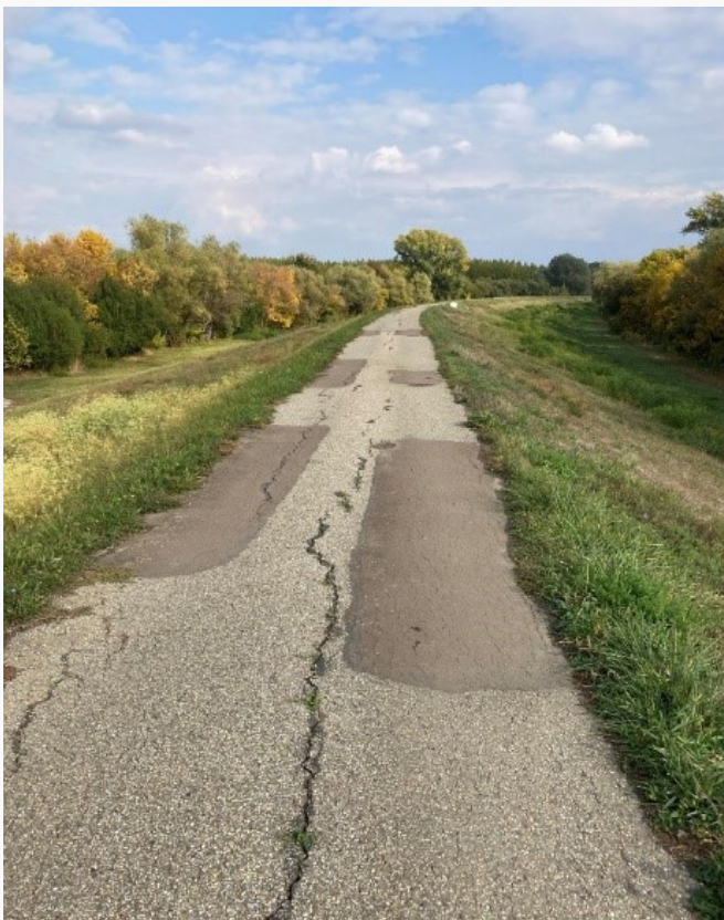
1. A ÉS B KÉP: REPEDEZETT TÖLTÉSKORONA-BURKOLAT ÉS A VÍZOLDALI RÉZSÚN MEGJELENŐ MERŐLEGES REPEDÉSEK
