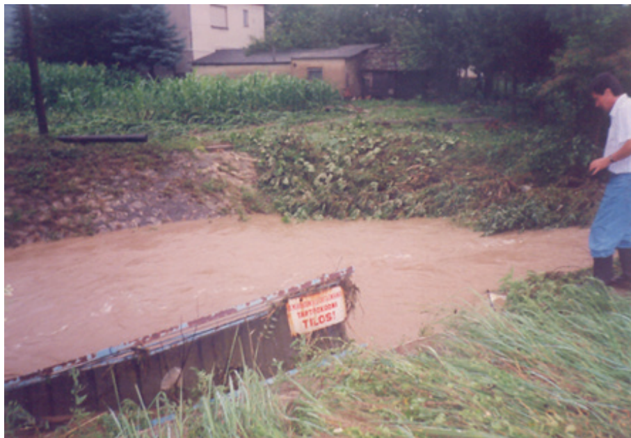
3. ábra. A tönkrement mérőhíd kb. 2 órával az árvízcsúcs után
