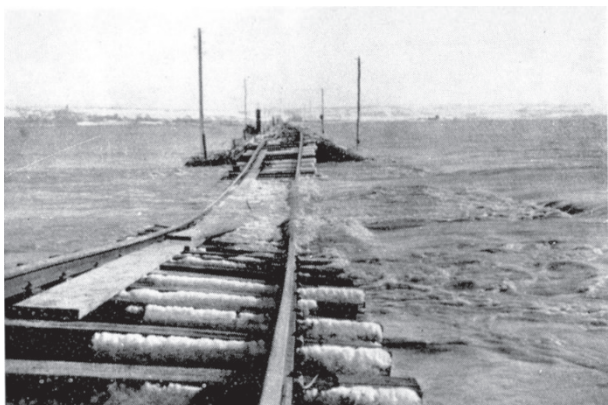
11. ábra. Elmosott vasúti pálya Dombóvárnál
