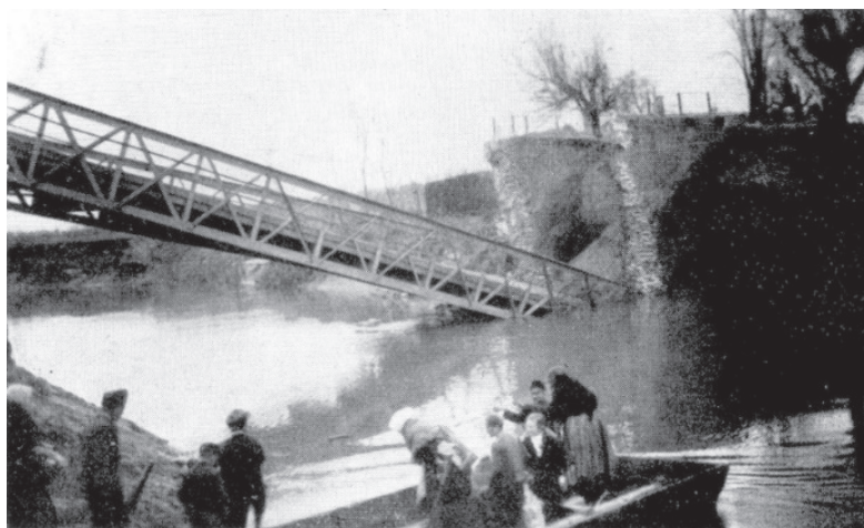
13. ábra. Az elpusztult szakályi közúti híd
