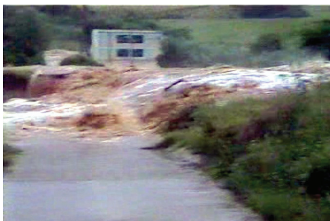
1. ábra. A vészárapasztót tönkreteszi az árvíz
