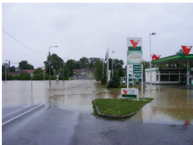
4. ábra. Baranya csatorna Sásd 66.sz. út
