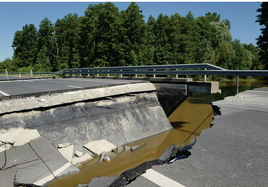
4. ábra. A heves esőzés miatt megáradt Rinya patak leszakadt hídja a 68-as főút Böhönye és Segesd közötti szakaszán július 27-én (Dr. Balatonyi László, OVF)
