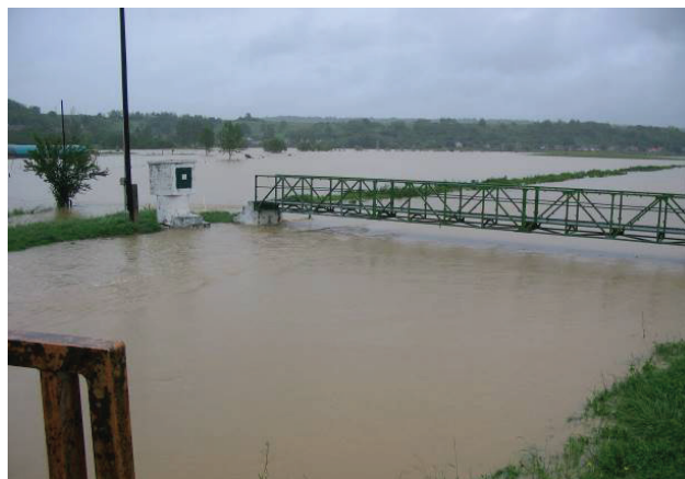
19. ábra. Baranya cs.-Csikóstöttös vízrajzi műtárgy
