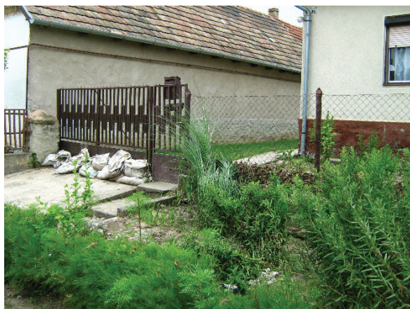
6. ábra. A mérőszelvényben megrongálódott partfal. A tetőző vízszint nyomai a házfalakon
