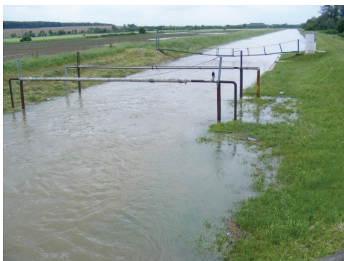
11. ábra. A Villány-pogányi vízfolyás vízhozammérő műtárgya az árvíz alatt
