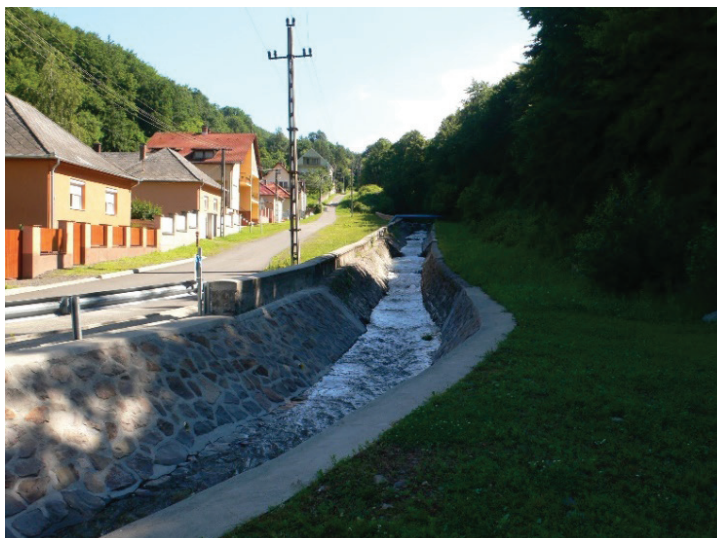
A Csörgő patak árvíz után kiépített medre, és az újjáépített patakparti épületek egy része
