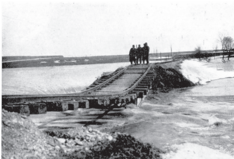
4. ábra. Tönkrement Zala híd a Túrje–Balatonszentgyörgy vasútvonalon
