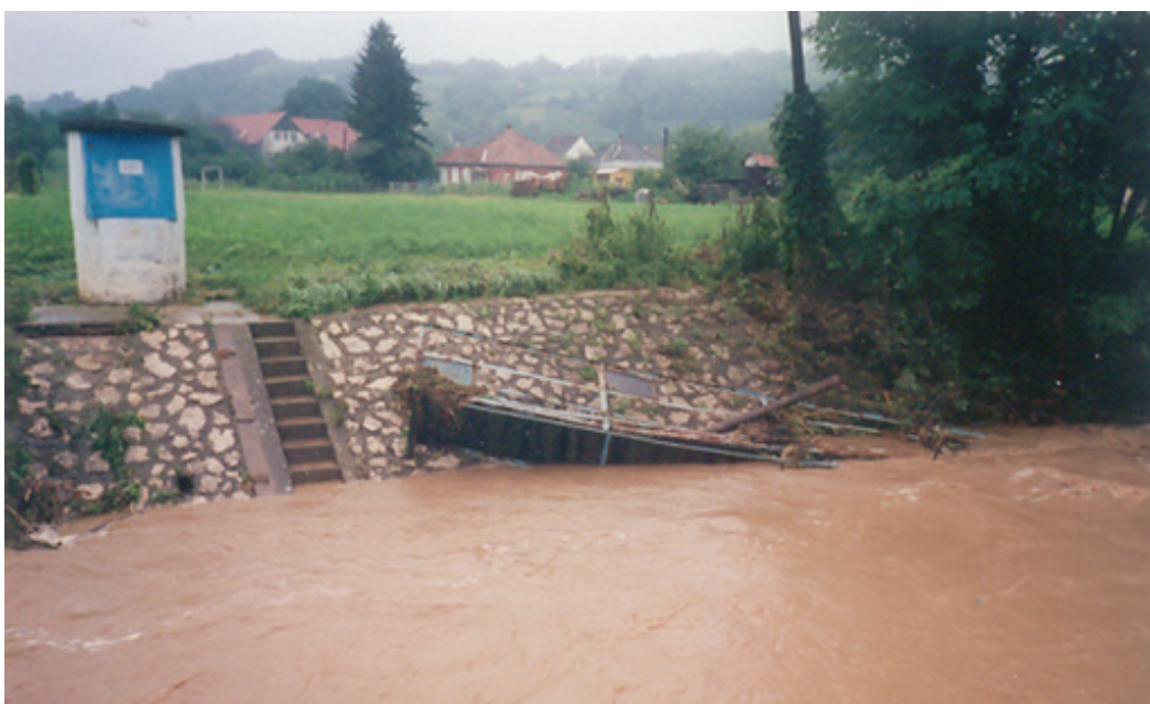
2. ábra. A magyaregregyi vízhozammérő szelvény az árvíz miatt tönkretett mérőhíddal (A felvétel időpontja: 1999. július 12. (hétfő) 16,00 óra
